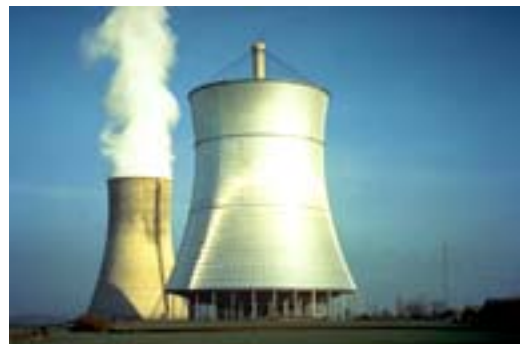
شکل ۱-۱- شمای کلی برج خنک‌کن کابلی
