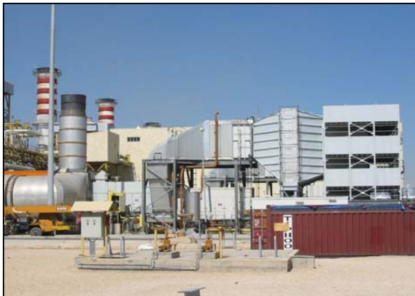
شکل (۱۲) نمایی از سیستم کولر تبخیری مدیا در نیروگاه سیکل ترکیبی فارس
