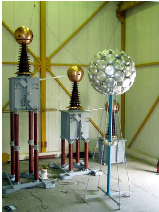
شکل ۲-الف- ترانسفورماتورهای فشارقوی کاسکاد ۳ پله
