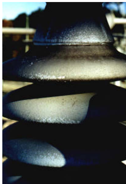
شکل (۲-۳): سطح مقره قبل از پوشش RTV
