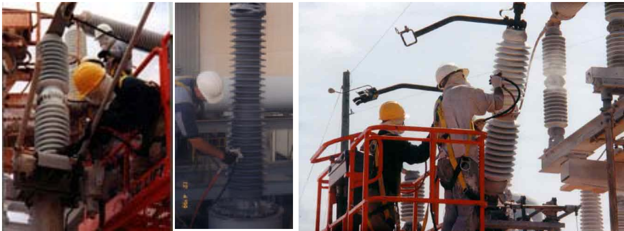
شکل (۲-۵): تصویری از اعمال پوشش RTV بر تجهیزات
