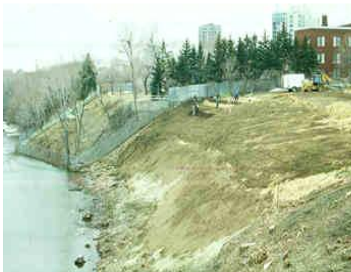
عکس شماره (4): آماده سازی ساحل رودخانه جهت حفاظت توسط کاشت گیاه
