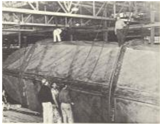
شکل ۱۶ - دوران بدنه یک شناور چوبی و اقدام برای تکمیل بخشهای باقیمانده آن.
