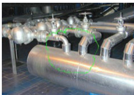
شکل 5- اتصال صحیح شاخه فرعی به اصلی کاندنس برگشتی
