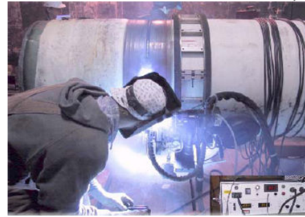
شکل 8- استفاده از دستگاه Zeromag برای مغناطیس زدایی یک خط لوله زیر زمینی
