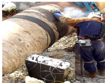
شکل 6- مغناطیس زدایی یک خط لوله گاز
