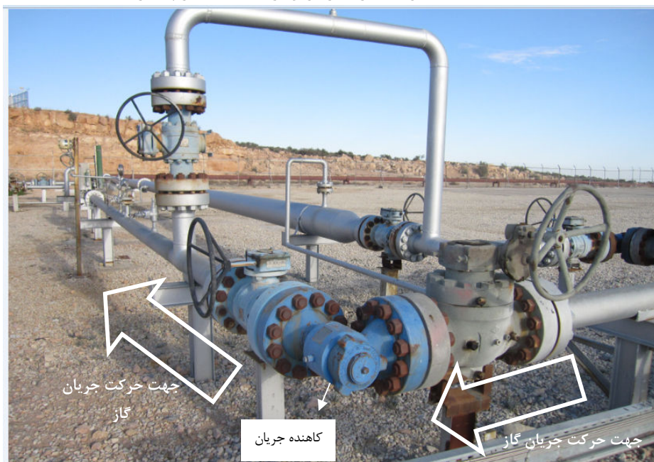
شکل 1- تغییر مسیر جریان در کاهنده ثابت سر چاه گازی
